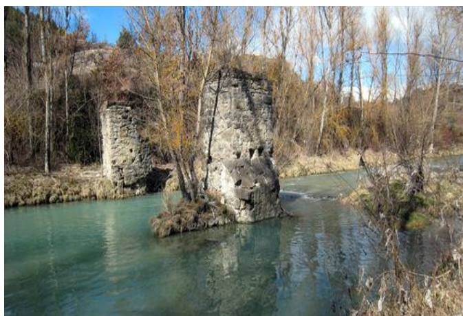
Restos del primitivo Puente de Sabiñánigo sobre el Gállego
